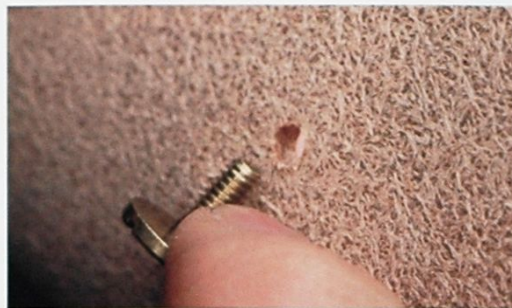
03 從背面安裝原子鉤的螺絲，如果不好安裝的話，可以利用轉螺絲的要領來轉動。
