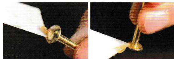
05 在釘頭表面及內側塗上橡膠糊。
